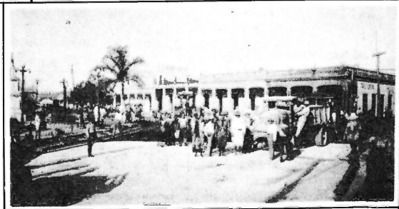
VICTORIA DE LAS TUNAS. —Vista del parque "Vicente García" frente al cual cruza la Carretera Central. Puede verse a los obreros finalizando las obras de esta ruta que ya enlaza todas las provincias. (Foto J. Hernández).
